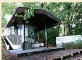
篠岡47号窯保存施設(覆い屋)
